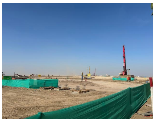
整地作業が進むタタの工場建設予定地
