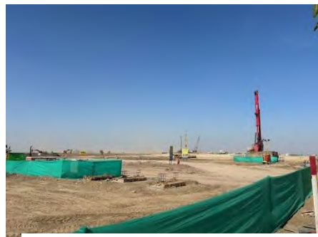
作業が進むタタの工場建設予定地
